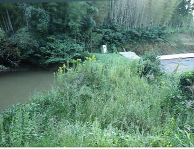
堤ヶ迫 堤体状況
