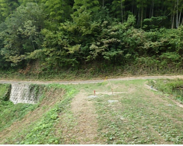
鳥越 堤体状況
