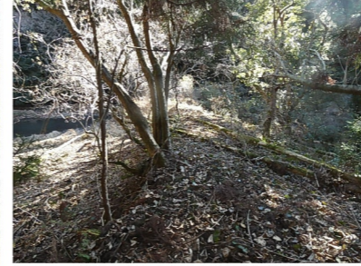
大牟田池 堤体状況
