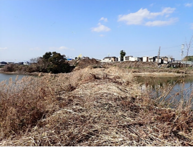
尾田上ため池 堤体状況
