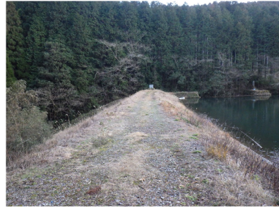
親ヶ田ため池 堤体状況
