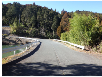
弓掛(古)ため池 堤体状況
