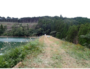
小川内ため池 堤体状況
