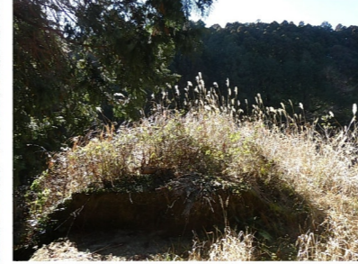
木浦ため池 堤体状況
