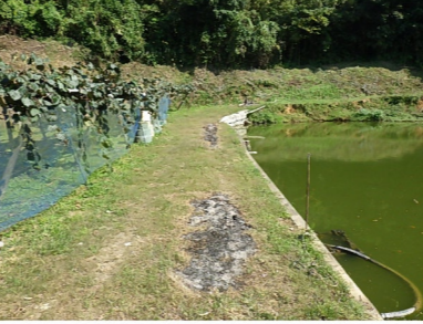
枯木谷 堤体状況
