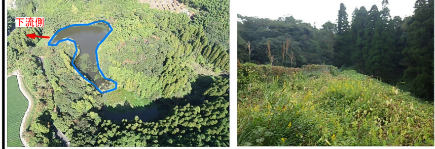
狗山谷ため池 空撮 狗山谷ため池 堤体状況
