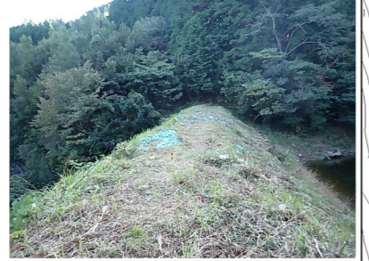
樋ノ口ため池 堤体状況
