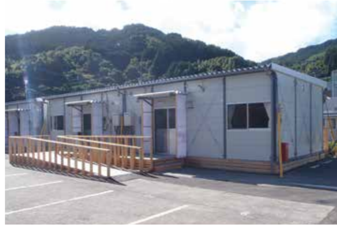
▲黒木地域交流センター駐車場に建設された仮設住宅
