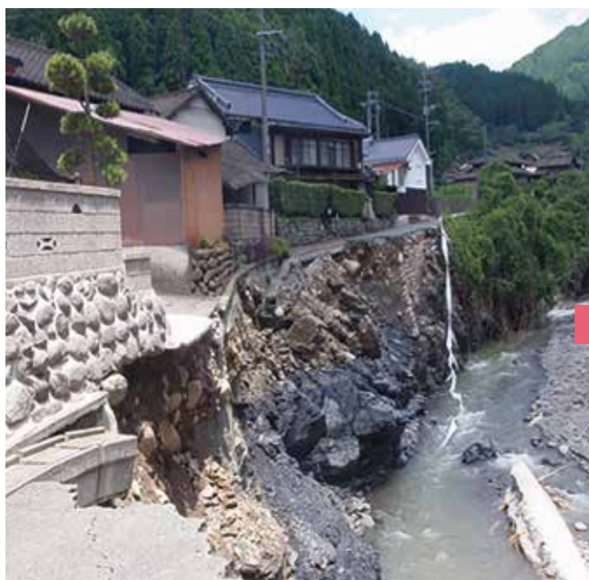
▲県道後川内黒木線 黒木町釈形付近(工事前)
