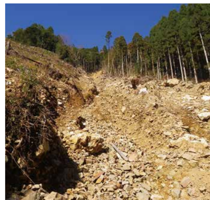
▲星野村字イラノ迫(工事前)
