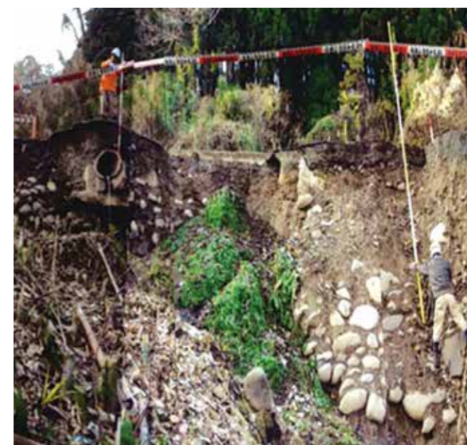
▲市道石原剣ヶ淵線 黒木町(工事前)
