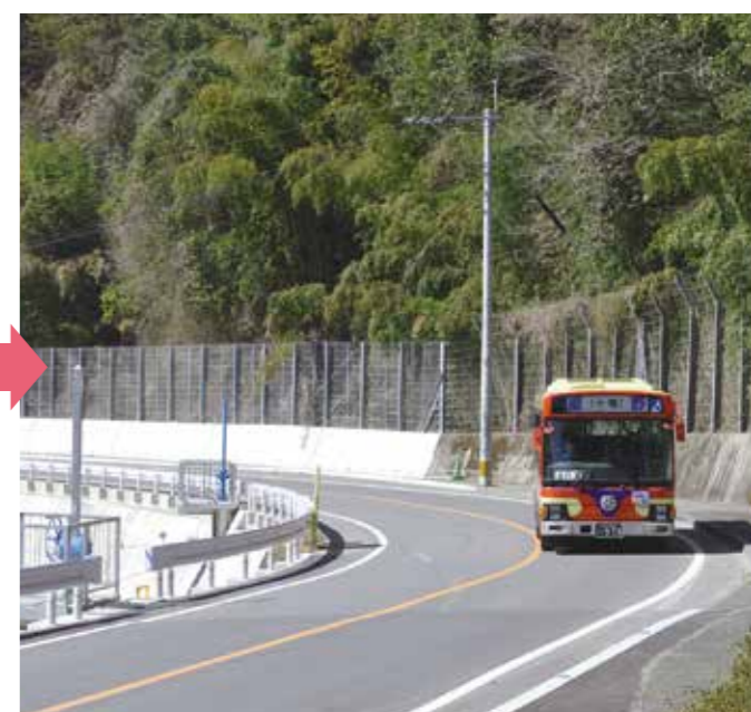
▲県道八女香春線 星野村コウモリ岩付近(復旧工事後)
