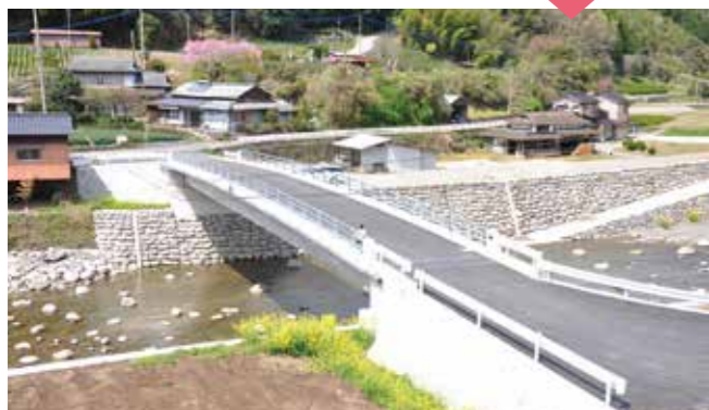
▲市道内宮～長瀬線 長瀬橋(復旧工事後)
