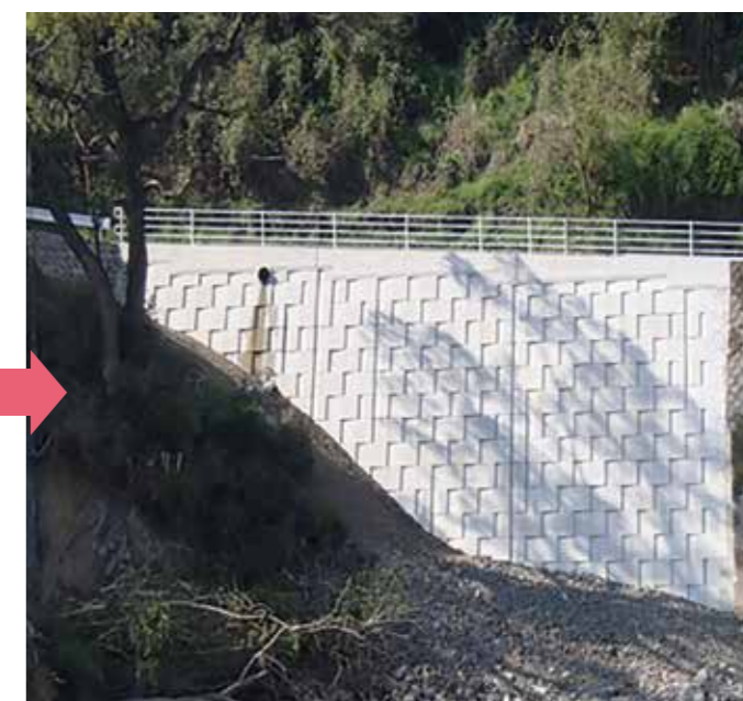
▲市道石原剣ヶ淵線 黒木町(復旧工事後)
