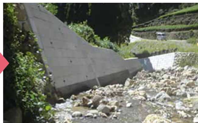
▲柏ノ木川 黒木町柏ノ木付近(復旧工事後)
