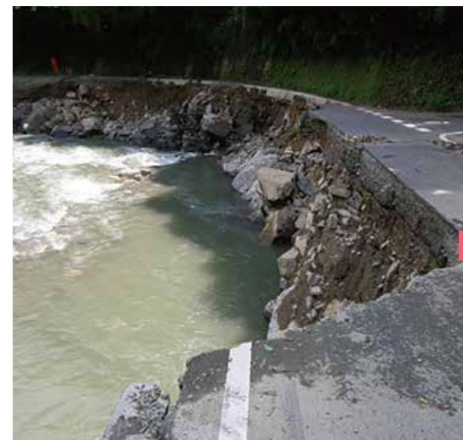
▲県道岩野黒木線 黒木町(工事前)
