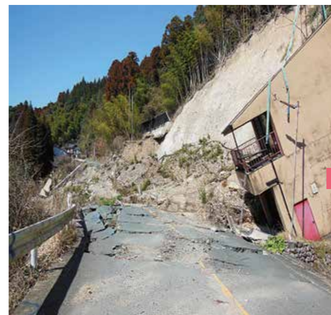
▲県道八女香春線 星野村三段付近(工事前)
