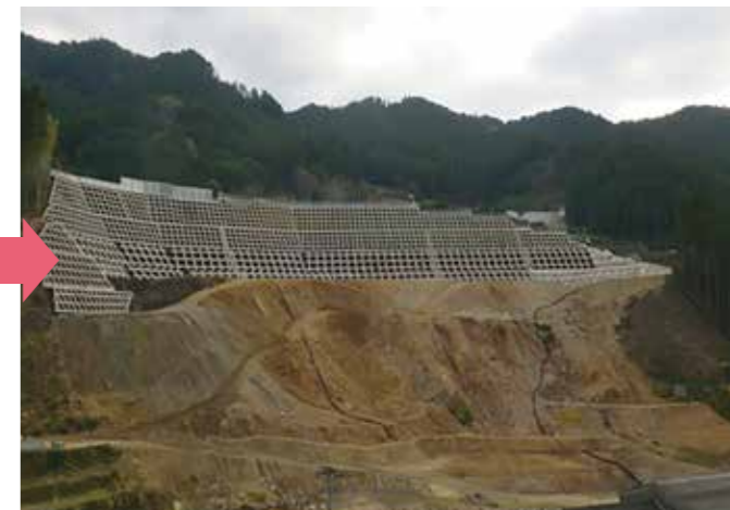
▲黒木町田代地区(復旧工事中)
