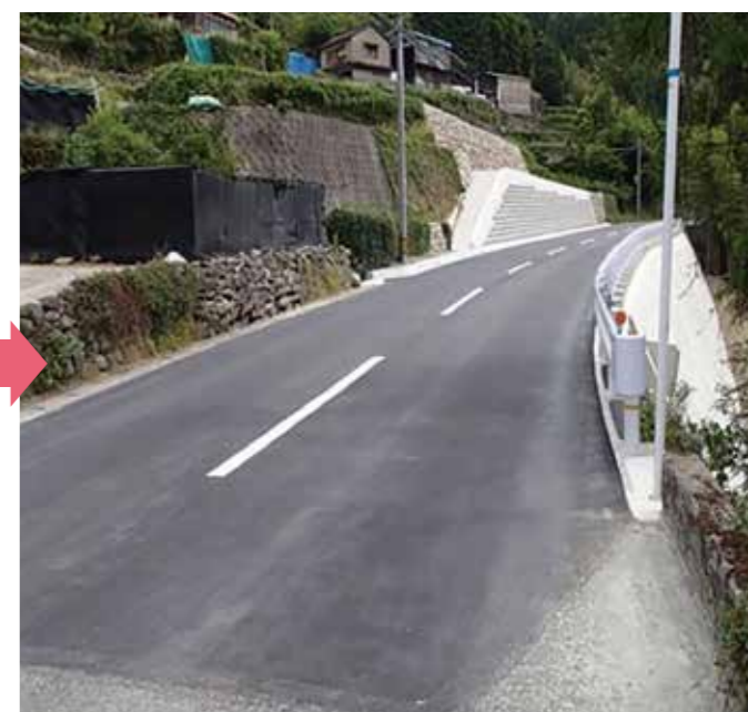
▲県道上横山星野線 星野村柱原付近(復旧工事後)
