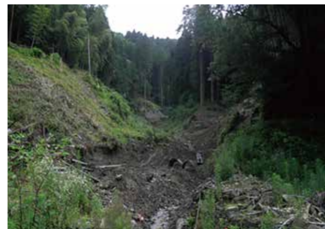
▲黒木町うどう川(工事前)
