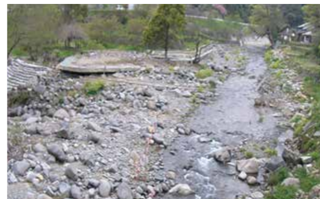
▲笠原川 黒木町きこの村付近(工事前)
