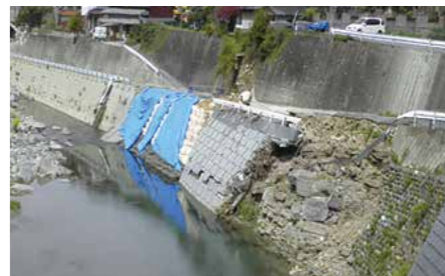
▲星野川 上陽洗玉橋付近(工事前)
