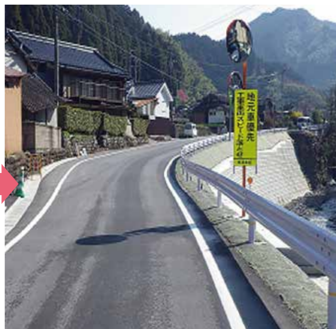
▲県道後川内黒木線 黒木町釈形付近(復旧工事後)
