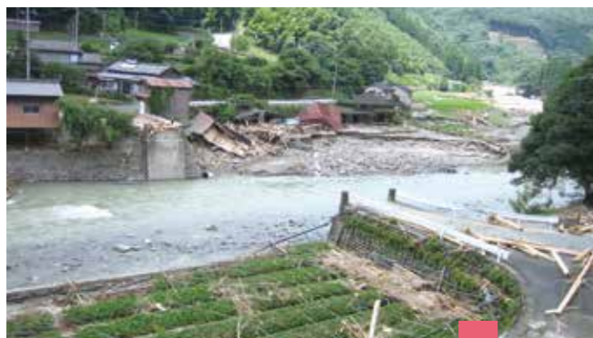
▲市道内宮～長瀬線 長瀬橋(工事前)
