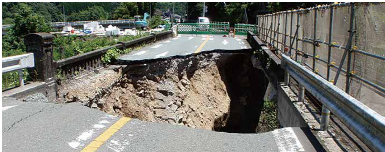
▲国道442号 黒木町須崎橋(工事前)
