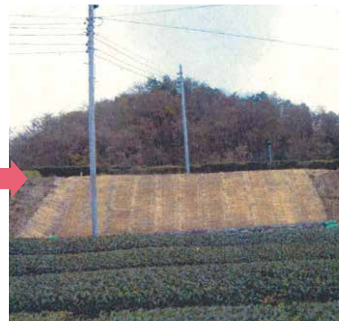
▲星野村茶屋ヶ谷(復旧工事後)
