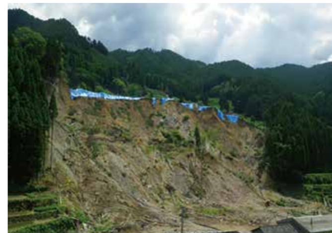
▲黒木町田代地区(工事前)
