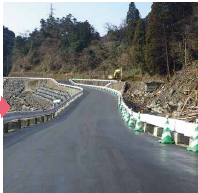
▲県道後川内黒木線 黒木町椿原付近(仮復旧工事後)
