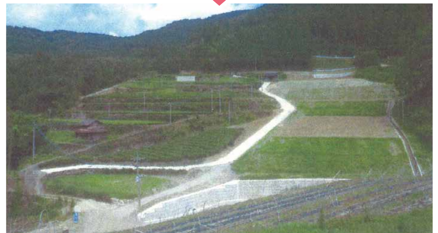
▲黒木町笠原(復旧工事後)
