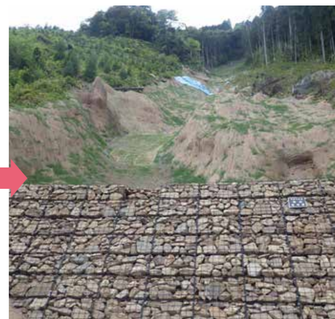
▲星野村字イラノ迫(復旧工事後)
