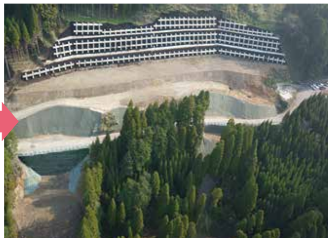
▲上陽町舟木地区(復旧工事中)
