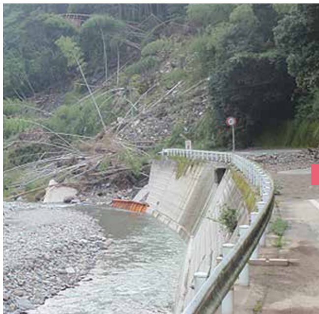
▲県道後川内黒木線 黒木町椿原付近(工事前)
