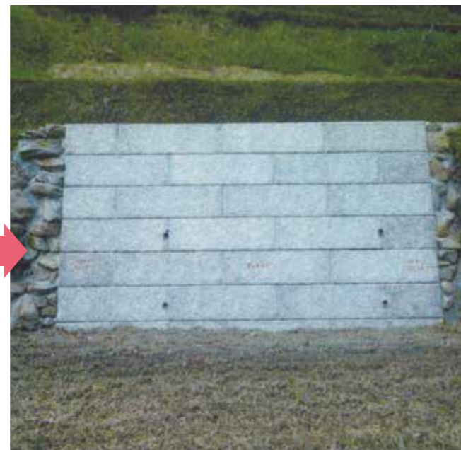
▲黒木町田代(復旧工事後)
