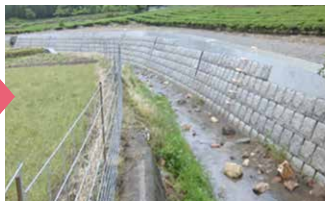
▲大牟田川 星野村大牟田付近(復旧工事後)
