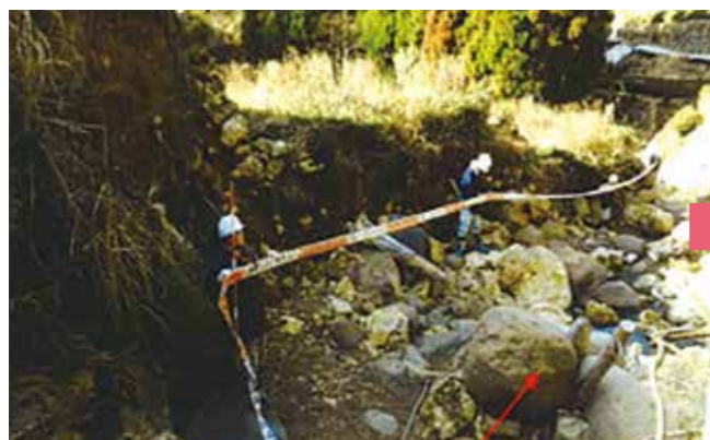
▲柏ノ木川 黒木町柏ノ木付近(工事前)
