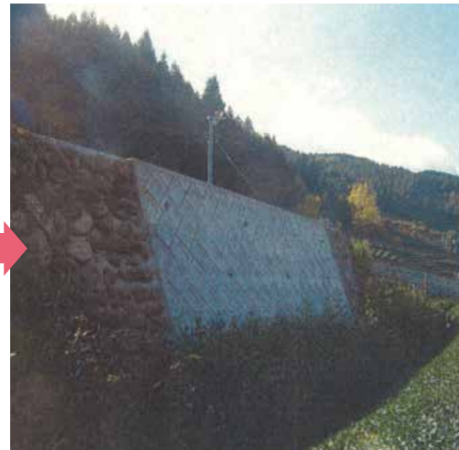
▲黒木町笠原(復旧工事後)
