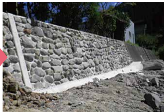
▲縦鶴川 矢部村縦鶴付近(復旧工事後)
