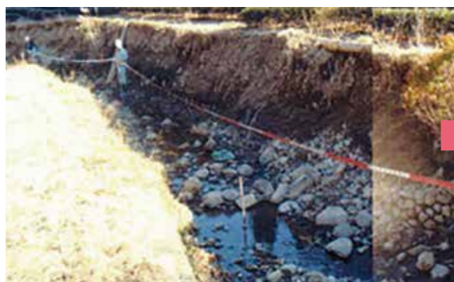
▲大牟田川 星野村大牟田付近(工事前)
