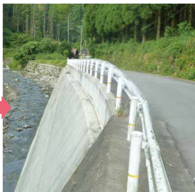
▲市道川向～滝の脇線 星野村(復旧工事後)
