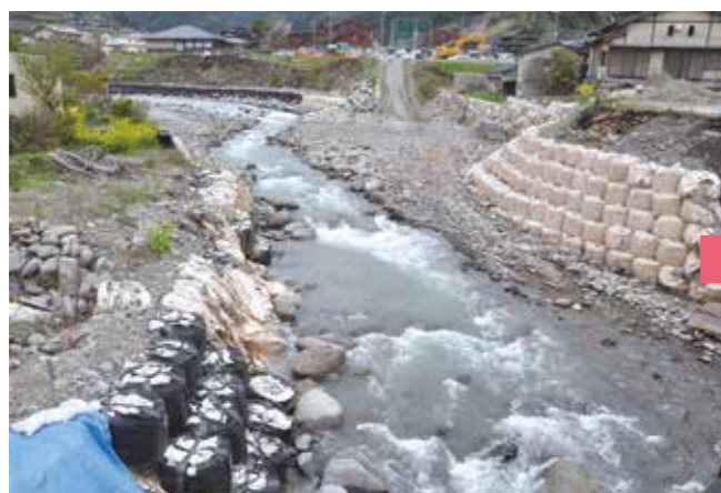
▲龍川内川 星野村天神橋付近(工事中)
