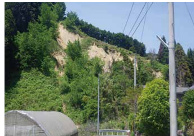
▲黒木町下名地区(工事前)
