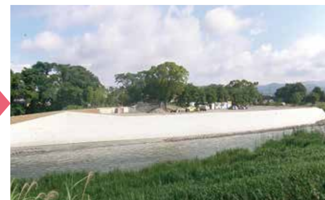
▲矢部川 津江付近(復旧工事後)
