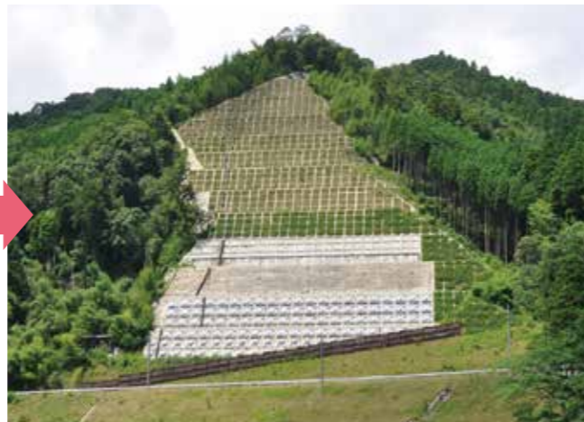
▲星野村三段(尾迫)(復旧工事中)
