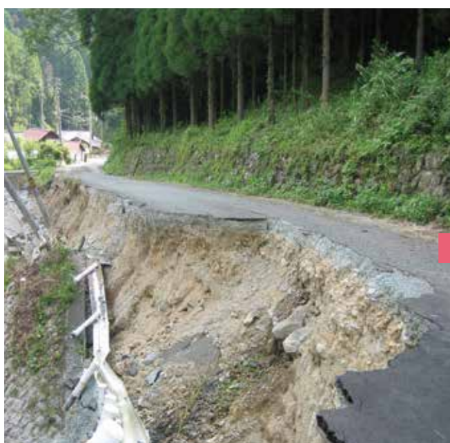
▲市道川向～滝の脇線 星野村(工事前)
