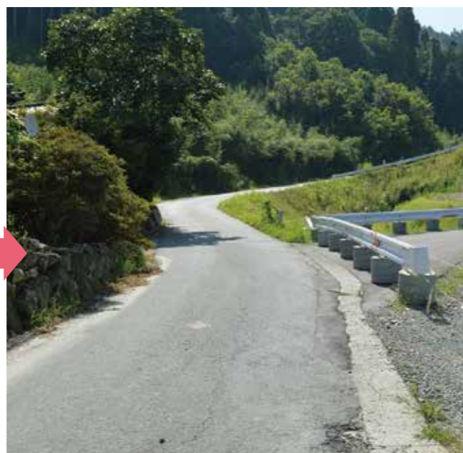
▲市道星野～黒木線 星野村(復旧工事後)
