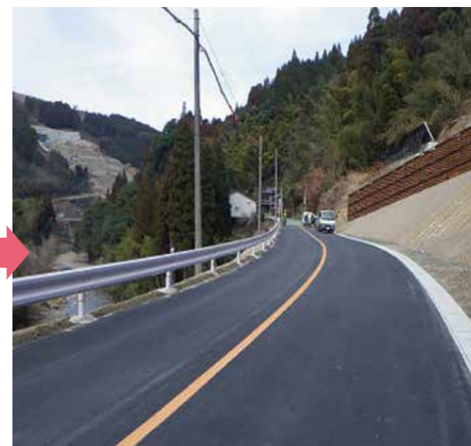
▲県道八女香春線 星野村三段付近(復旧工事後)
