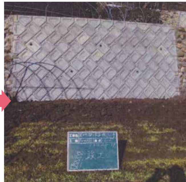
▲黒木町笠原(復旧工事後)
