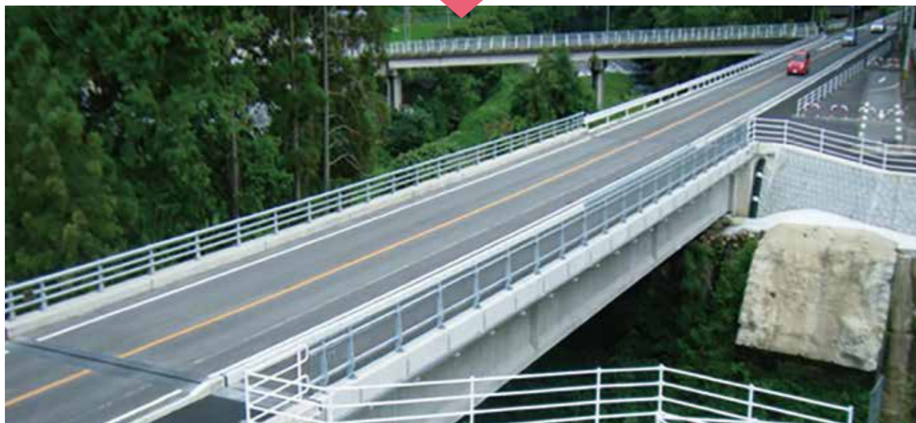
▲国道442号 黒木町須崎橋(復旧工事後)
