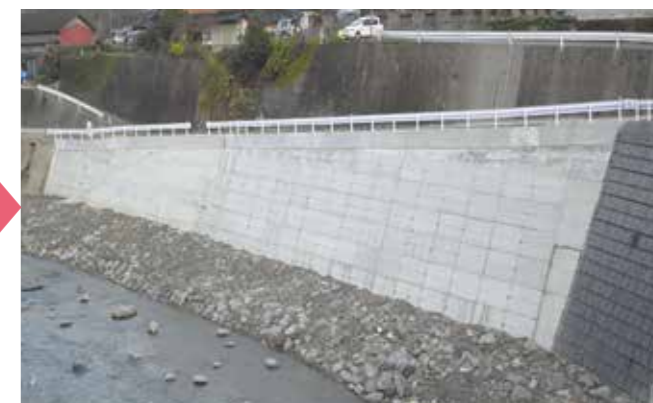
▲星野川 上陽洗玉橋付近(復旧工事後)
