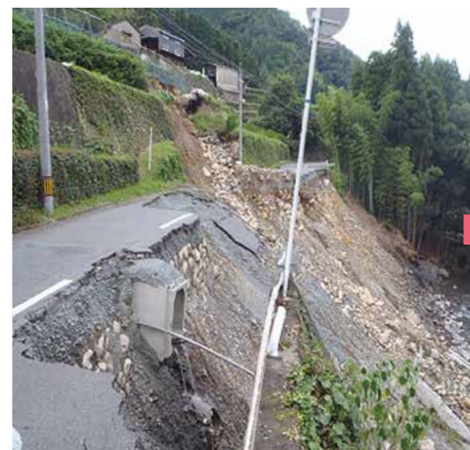
▲県道上横山星野線 星野村柱原付近(工事前)
