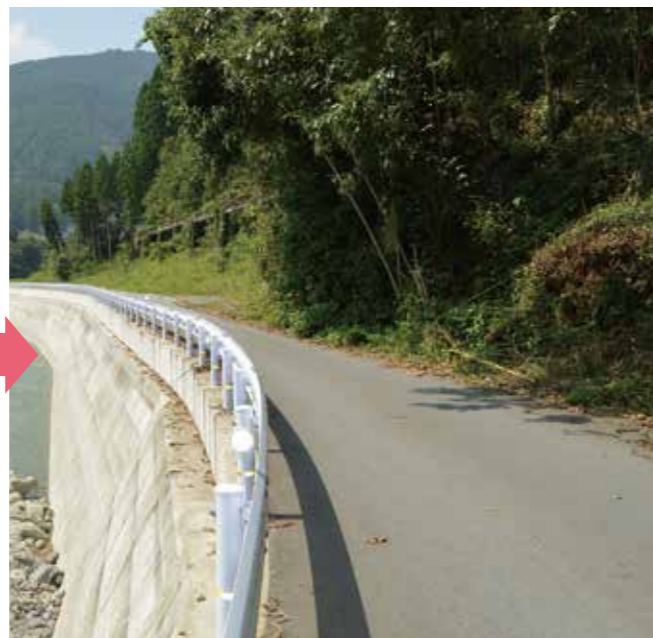
▲市道光延～土穴線 星野村(復旧工事後)
