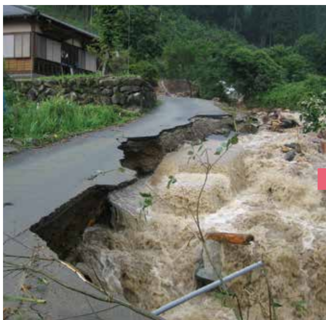
▲市道星野～黒木線 星野村(工事前)
