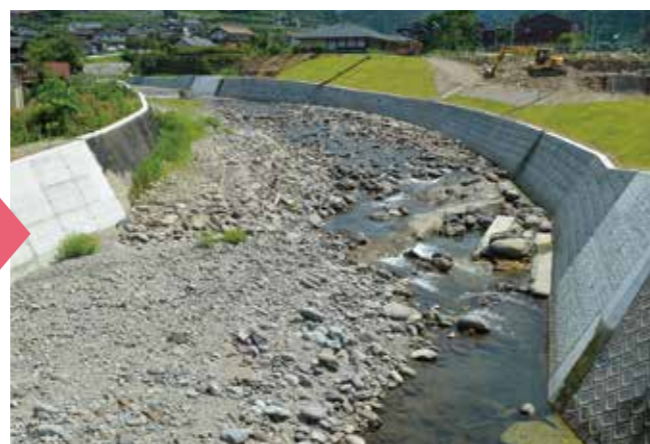
▲龍川内川 星野村天神橋付近(復旧工事後)
