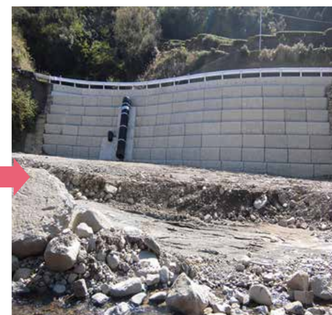
▲市道靈巖寺田代線 黒木町(復旧工事後)
