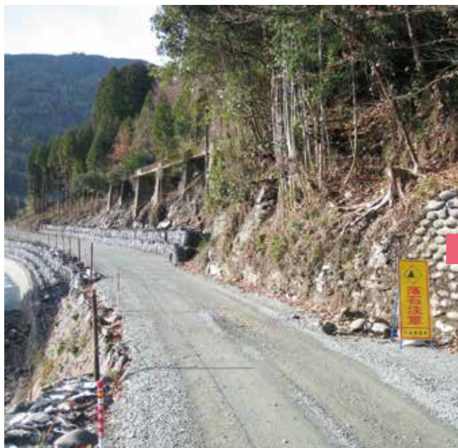
▲市道光延～土穴線 星野村(工事前)
