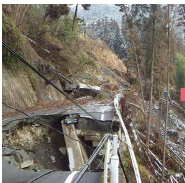
▲県道後川内黒木線 黒木笠原不動館手前付近(工事前)
