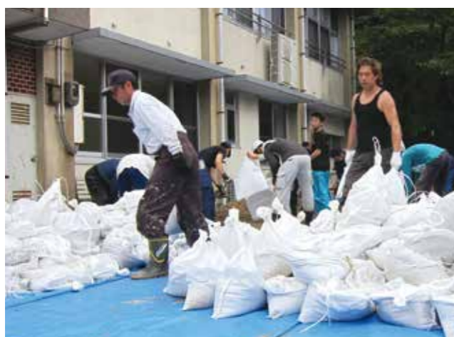
▲土のうづくり
