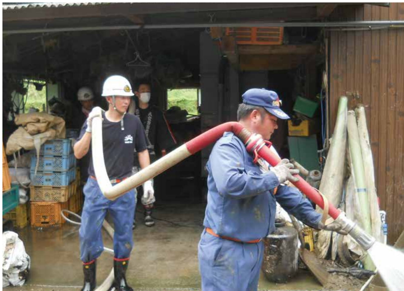
▲住宅の土砂除去
