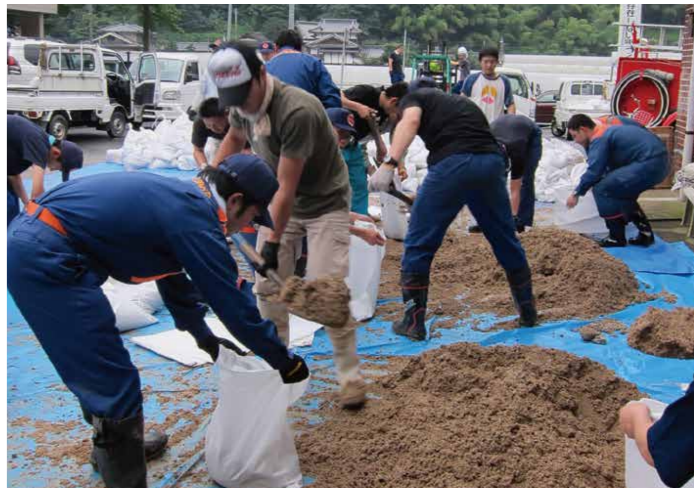
▲土のうづくり
