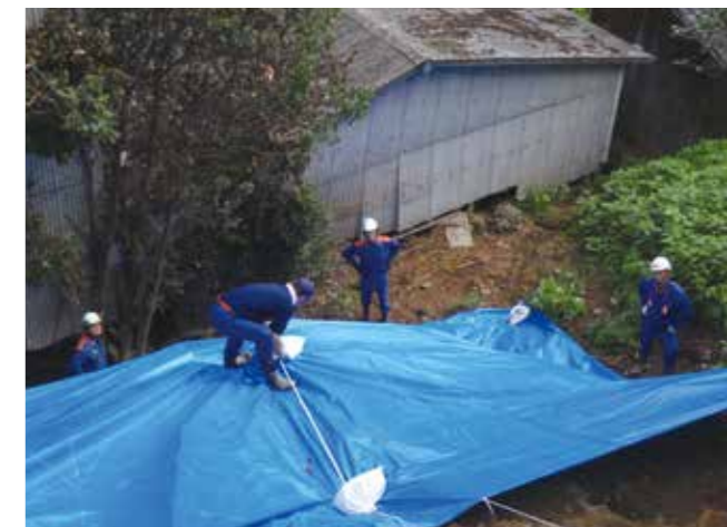
▲二次災害防止のためのシート張り
