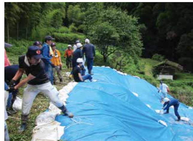
▲二次災害防止のためのシート張り
