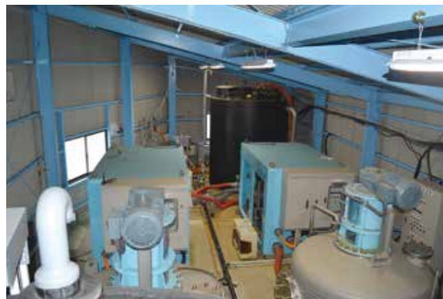
▲星野村小野地区簡易水道仮浄水場(平成27年9月時点)
