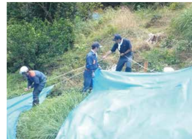
▲二次災害防止のためのシート張り
