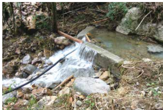
▲星野村本星野地区簡易水道 取水口
