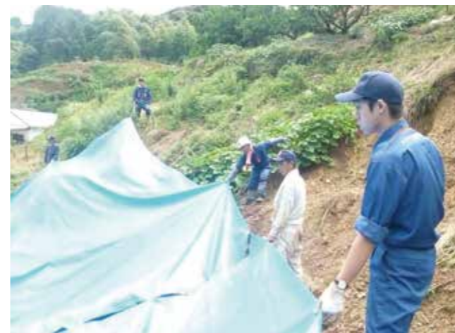
▲二次災害防止のためのシート張り
