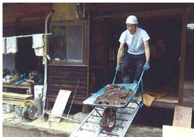
▲家屋の土砂出し・片付け
