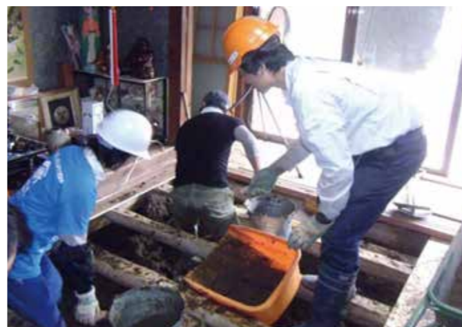
▲家屋の土砂出し・片付け
