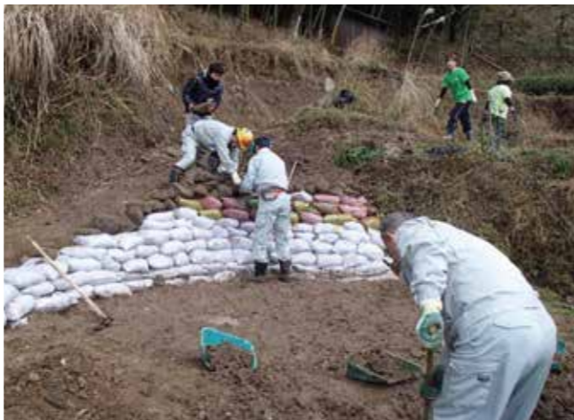
▲土のう袋による土羽の復旧
