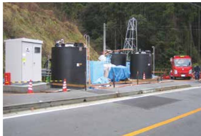
▲星野村小野地区簡易水道仮浄水場(平成24年12月時点)
