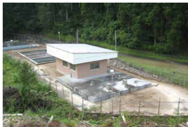
▲星野村小野地区簡易水道 浄水場
