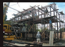
②組立て初日。クレーンを使って組み上げる
