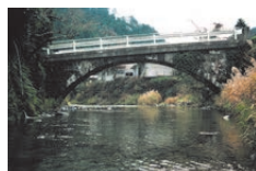
⑰ 八重谷橋 [上陽]
