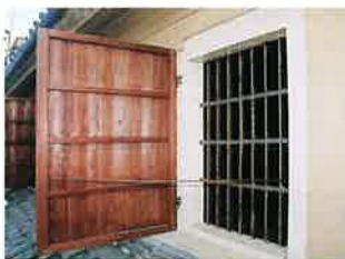
漆喰壁と片開きの鉄格子窓（二階）
