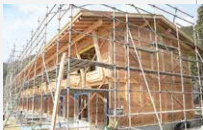
八女材を使った住宅の棟上げ
