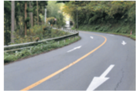
S 状カーブが続く国道 442 号
