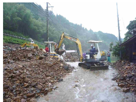
▲集中豪雨による土砂災害
