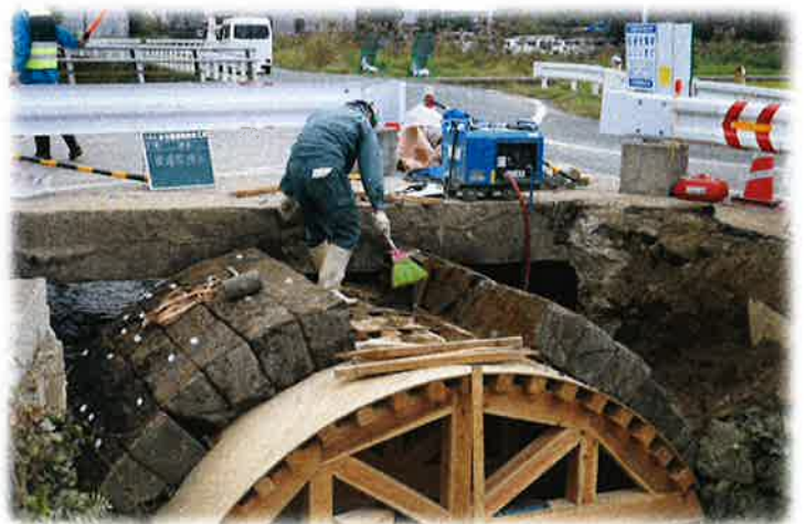
解体作業の様子
