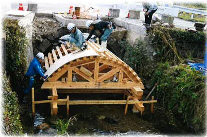
支保工設置の様子
