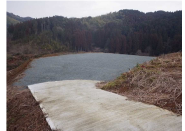
▲ 整備された広場
