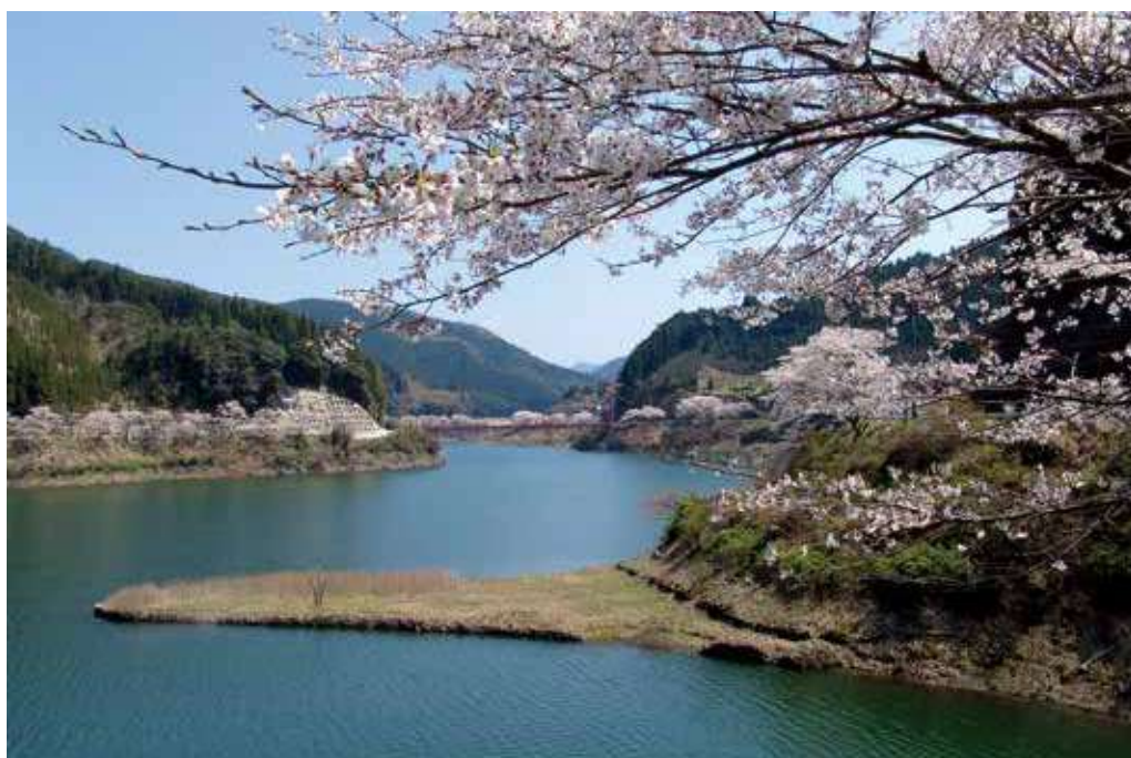
日向神ダム（矢部）
