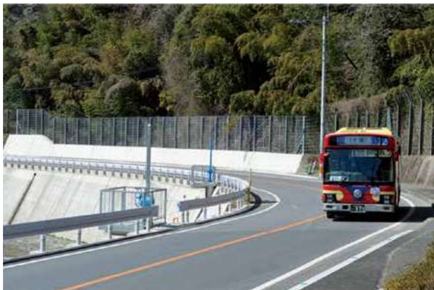
県道八女香春線 星野村コウモリ岩付近（復旧工事後）
