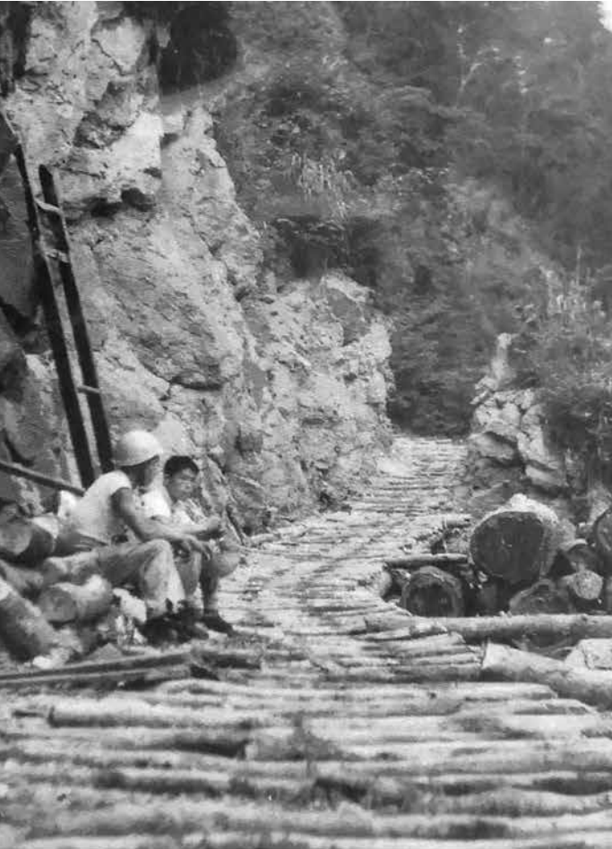
栗の木が敷かれた木馬道。木材は重量があるため、木馬や木馬道には種油を敷いて滑りをよくしました。(昭和35年御側八ツ滝下の木馬道)
