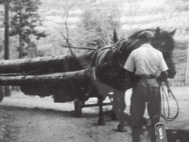
電柱材を台車に乗せて、馬で搬送する様子
