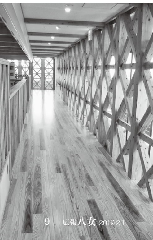
議会棟の木の耐力壁と廊下
