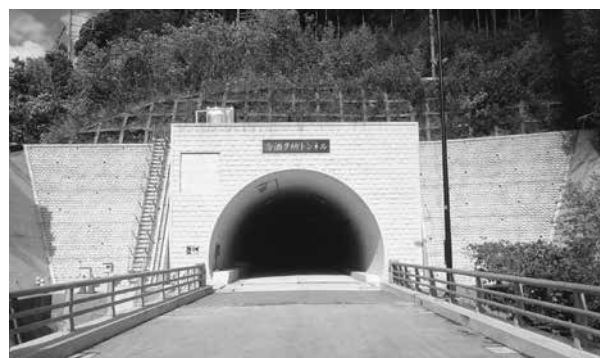
長年開通が待たれていた合瀬耳納トンネル(県道八女香春線)。延長2,616 mの2車線の道路トンネルです。
