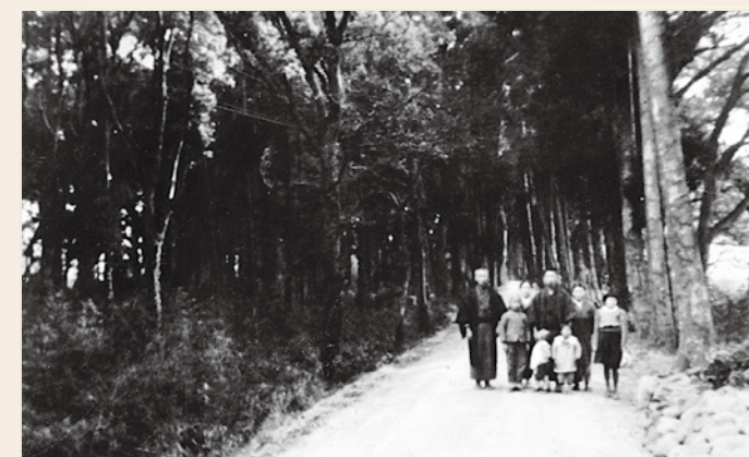
千間土居 元禄8（1695）年に築かれたこの堤防には補強のために竹木が植えられた。（立花）
