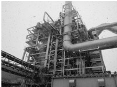
真庭バイオマス発電株式会社 ←(真庭市)
