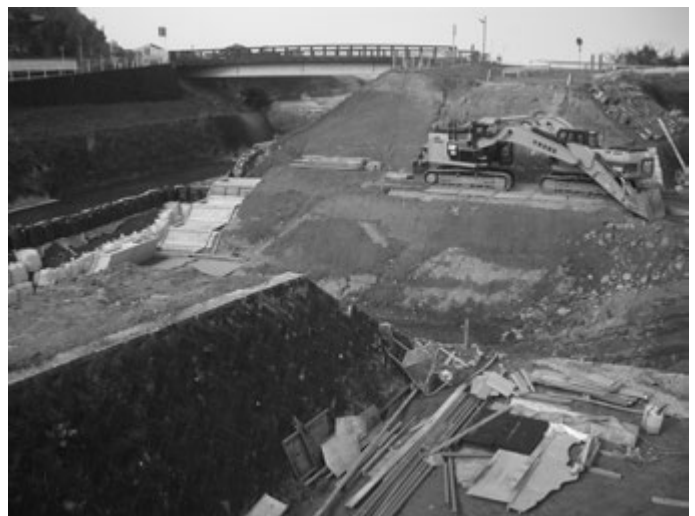
山下地区水門工事の様子
