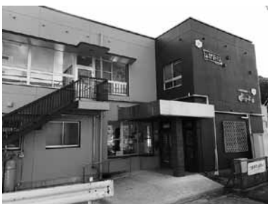
階段昇降機設置により安全性確保
