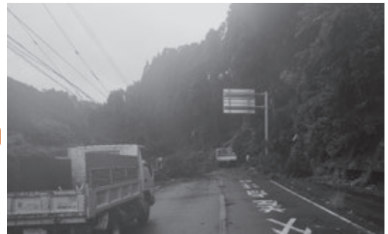
風倒木により被災した電線・電話線の復旧作業
