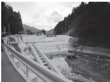
頭首工の復旧 (星野村十箆地区)
