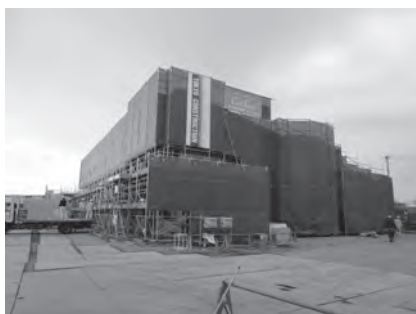
建設中の 子育て支援総合施設
