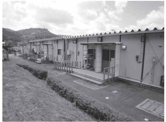
黒木総合支所に隣接する仮設住宅
