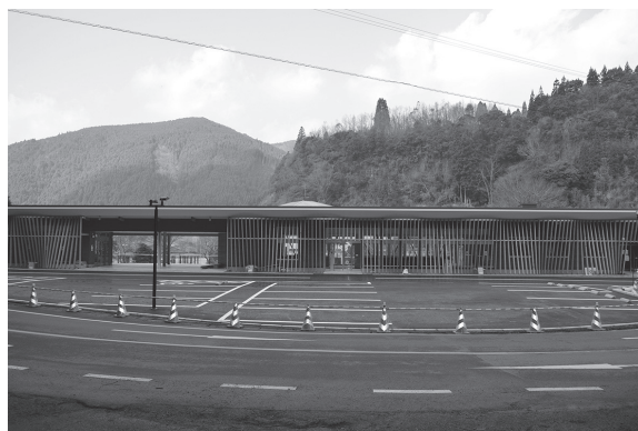
矢部地区観光物産交流施設
