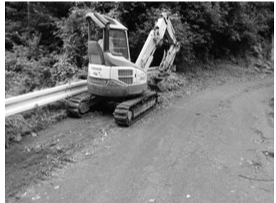
路肩整備(市道尾道山口線)
