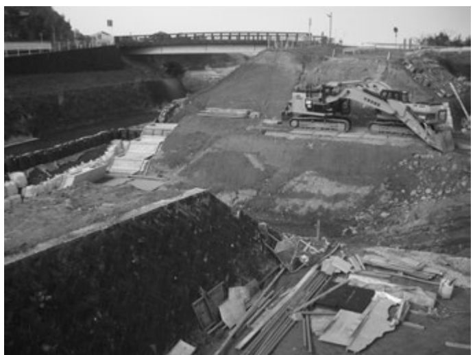
山下地区水門工事の様子
