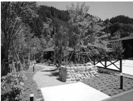
⑤矢部地区山村滞在施設
