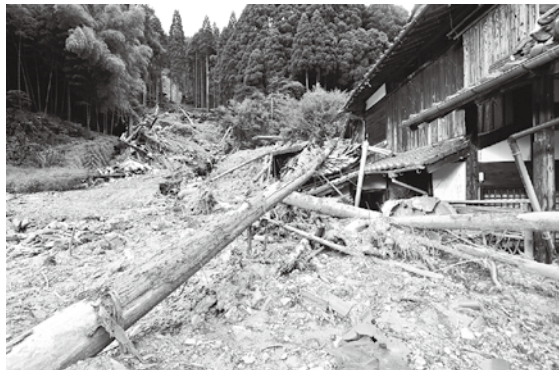
平成24年九州北部豪雨災害時
