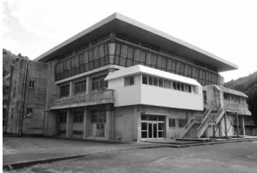
黒木中学校屋内運動場
