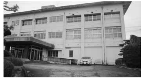
川崎小学校現況
