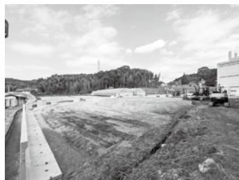
新校舎の建設予定地
