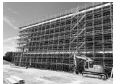
工事中の黒木中学校屋内運動場
