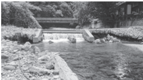
②黒木町木屋地内の一ノ渡瀬堰
