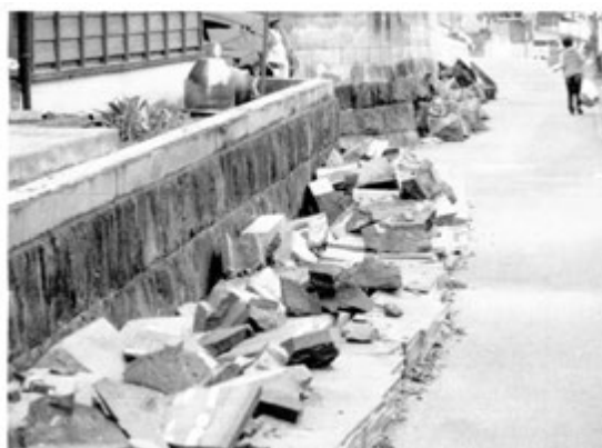
地震によって崩壊したブロック塀 (八女市外)
