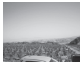
県営中山間・農用地開発整備事業現場 (立花町山下地区)
