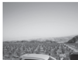
県営中山間・農用地開発整備事業現場 (立花町山下地区)
