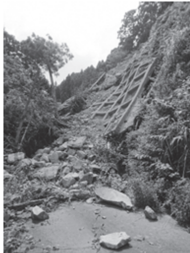
③星野村の林道古城線崩壊現場
