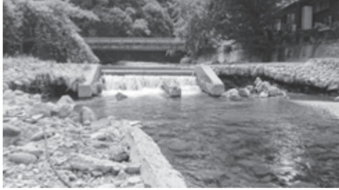
②黒木町木屋地内の一ノ渡瀬堰
