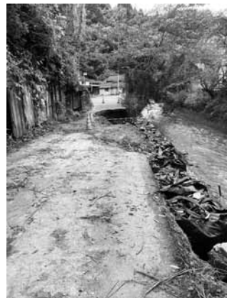
大雨で通行止めになった県道
