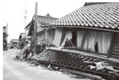
能登半島地震で被災した家屋 (石川県珠洲市)
