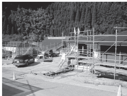
矢部地区に建設中の山村滞在施設
