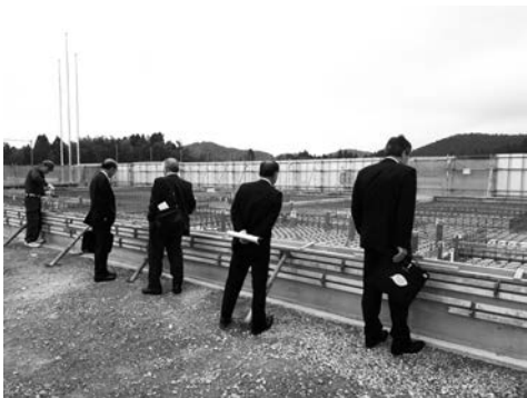
②クラブハウス建設現場を確認する委員
