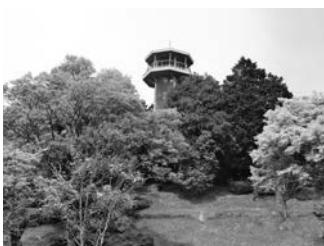
③解体予定の展望台
