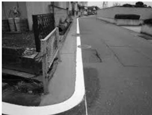
グリーンベルト施工例
