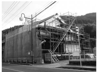
修復が進む伝統的建造物
